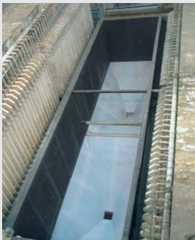
Защитная облицовка материалом РЕМАФЛОН
